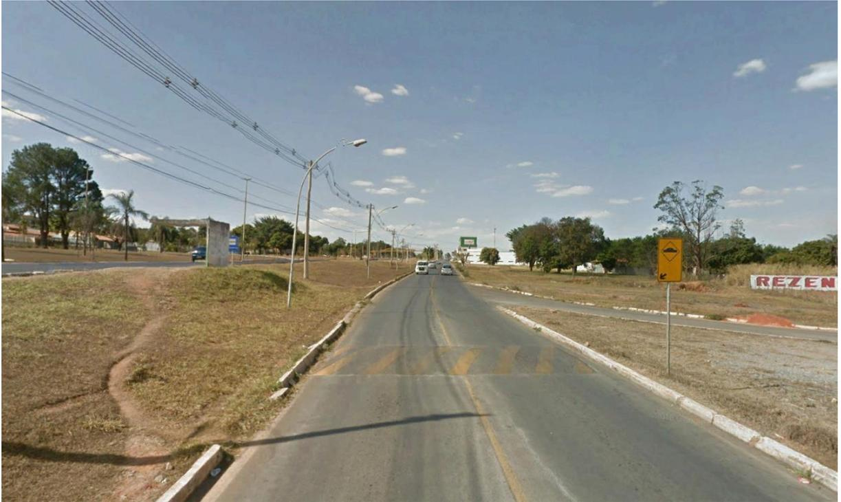
Figura 61: Ausência de calçadas e sinalização de pedestre para paradas de ônibus - Via marginal (Ponto 08)
