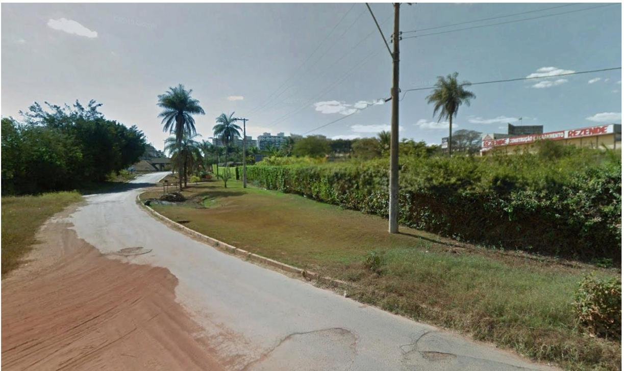
Figura 62: Ausência de calçadas e de drenagem na via lateral ao empreendimento (Ponto 09)
