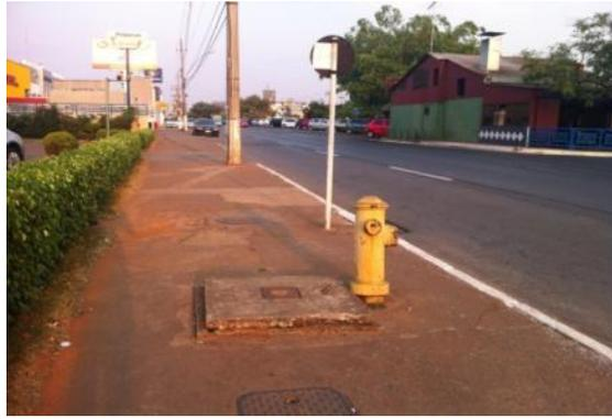
Figura 61: irregularidade na calçada e ausência de sinalização tátil.
